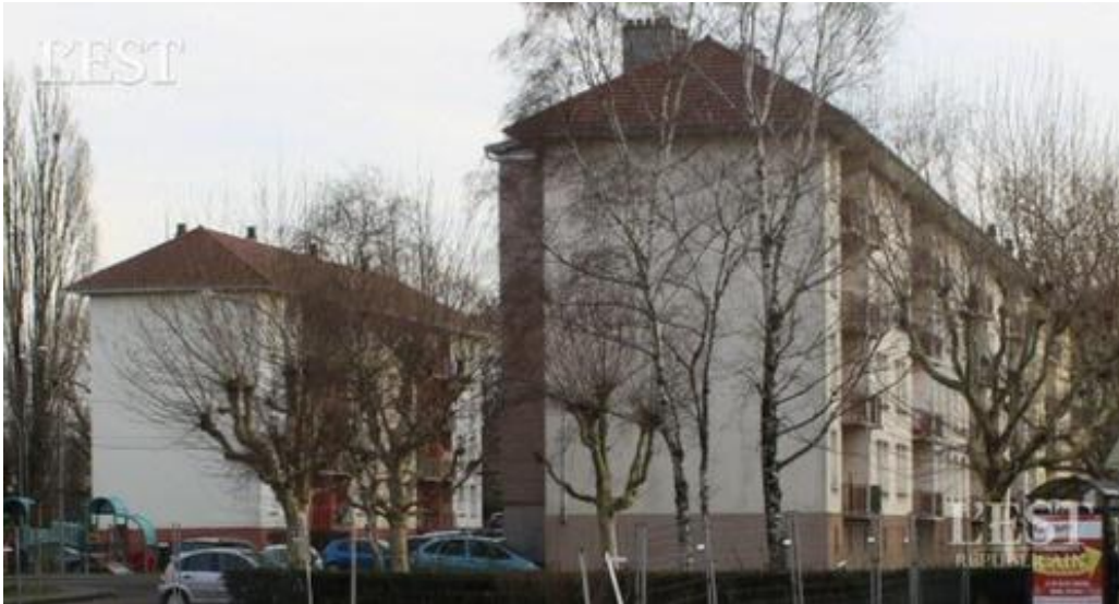
Les immeubles de la rue Victor-Hugo qui vont être rénovés.
