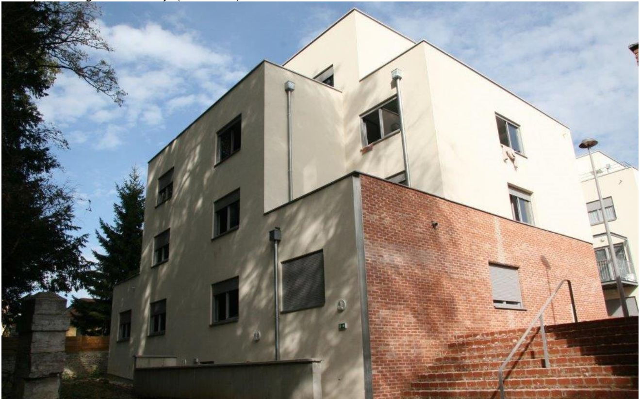
Besançon - 31 logements locatifs (Habitat 25)
